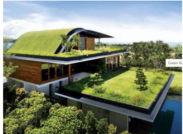
Gambar 7 Desain Green Cool Roof untuk refleksi panas dan retensi air hujan
